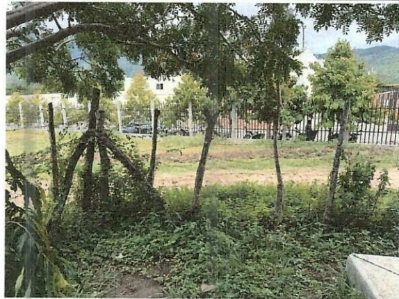
Foto 3: FOTOGRAFÍA DE ÁREA A INTERVENIR MEJORAMIENTO DEL MURO PERIMETRAL ÁREA LATERAL
